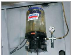
7. На фильтре применена автоматизированная система консистентной смазки фирмы ЛИНКОЛЬН для смазки всех трущихся поверхностей. Она отличается надежностью подачи смазки малыми порциями в необходимые точки с установленной периодичностью.
