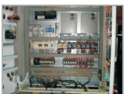
Система управления фильтром предусматривает автоматическое поддержание работы всех механизмов и устройств с аварийными блокировками для защиты от повреждений. Базовая комплектация выполняется на элементной базе «Шнайдер Электрик» или «Сименс». По желанию заказчика комплектация может быть выполнена и на другой элементной базе.
