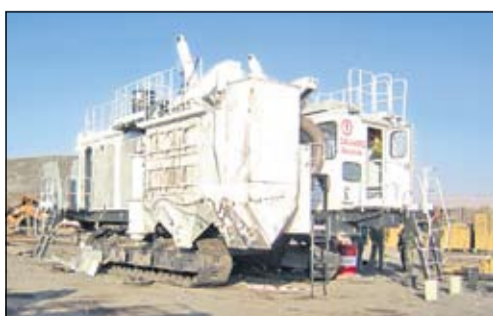
Монтаж нашего СБШ-250Д в карьере Хакасии
